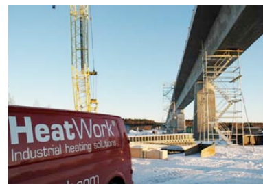
Uppvärmning vid betongarbete
