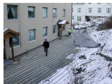
Uptining för grävandet av ny dränering
